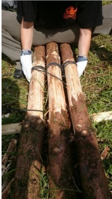
on passe la corde PP entre les troncs en faisant un 8
