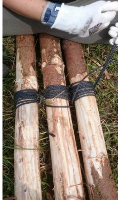
on passe la corde PP entre les troncs en faisant un 8
