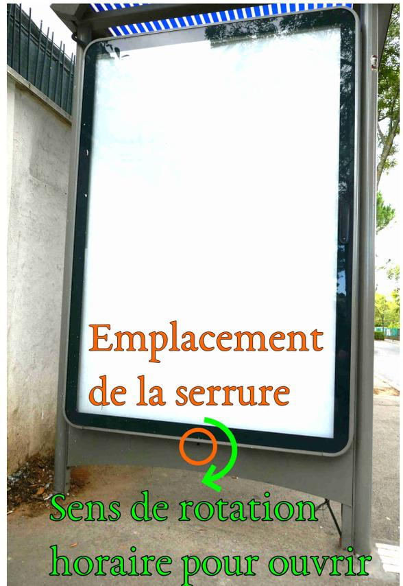
Les panneaux sont plus difficiles à ouvrir, il est pratique d'utiliser une clé à pipe pour faire levier sur la clé Allen.
