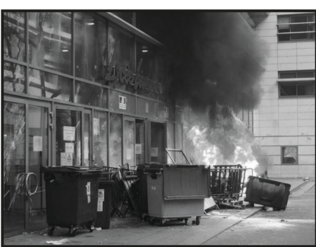
Levallois, vendredi 5 avril, au cours du blocus, la façade du lycée Léonard de Vinci flambe. Cet établissement fut élu prophétiquement « plus beau lycée d’Europe » il y a quelques années.
